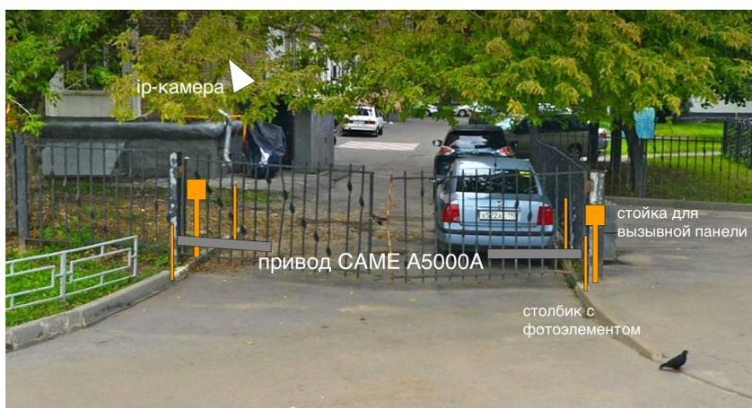
**Распашные ворота:** ширина 5 метров, высота 1,5. Оснащение: - комплект приводов САМЕ А5000А – 1шт; - стойки с вызывными панелями – 2шт; - стойки с фотоэлементами – 4шт; - ip-камера.
